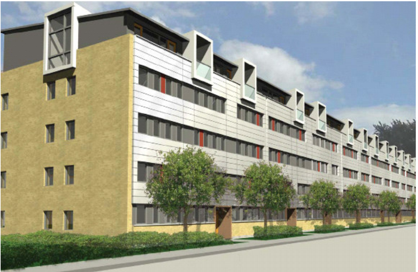
Den nye facade med altankarnapper og den efterisolerende facadebeklædning
