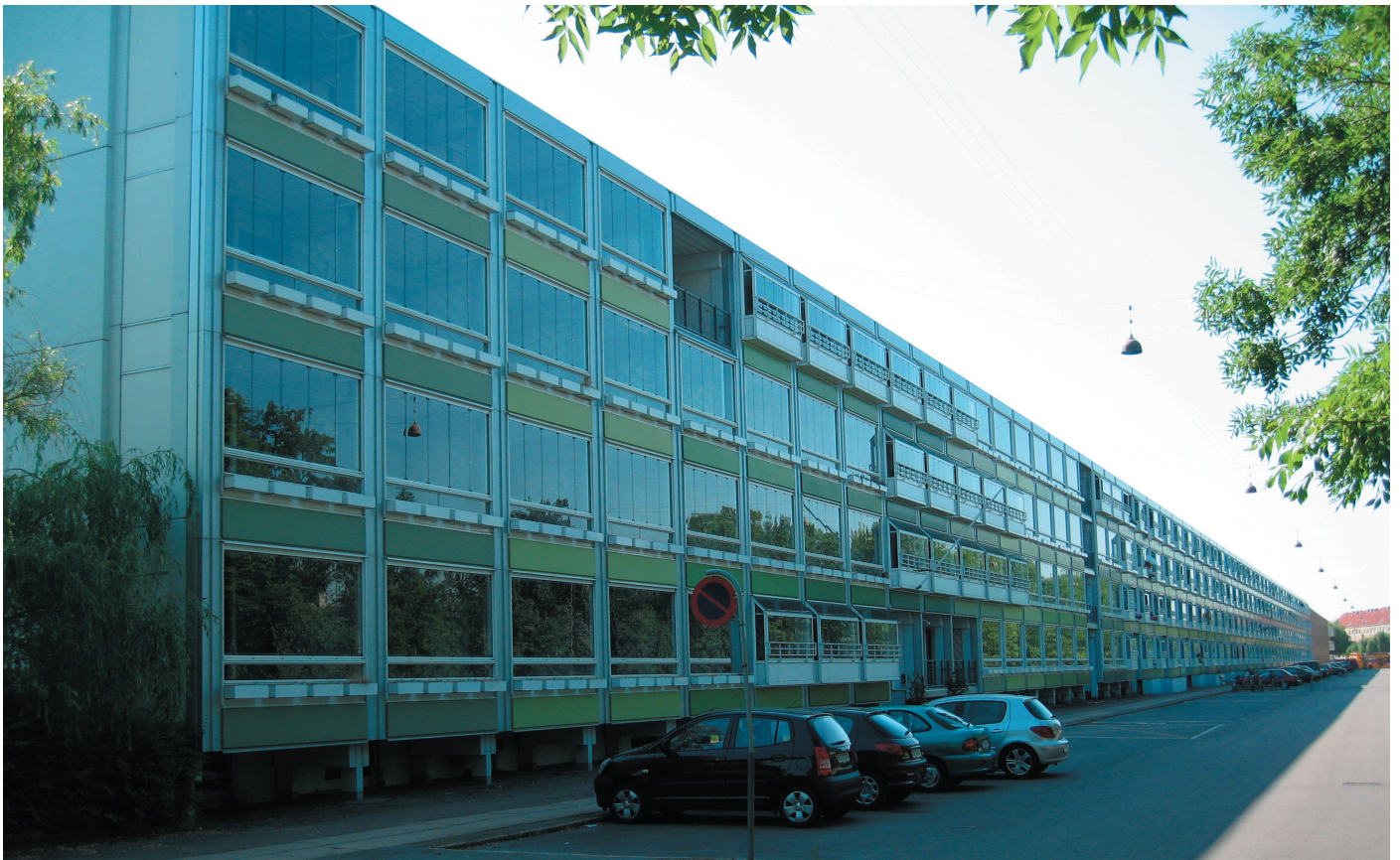
Eksisterende vestfacade, set fra nord Ryholtgård
