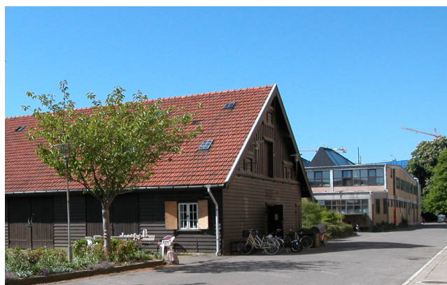
Bevaringsværdig bygning med opbevaring af materiel
