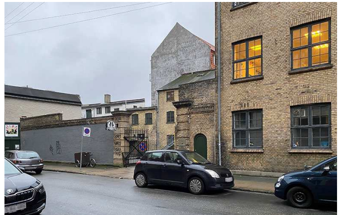
Fabrikskomplekset med murparti og forhus set fra Hannovergade.
