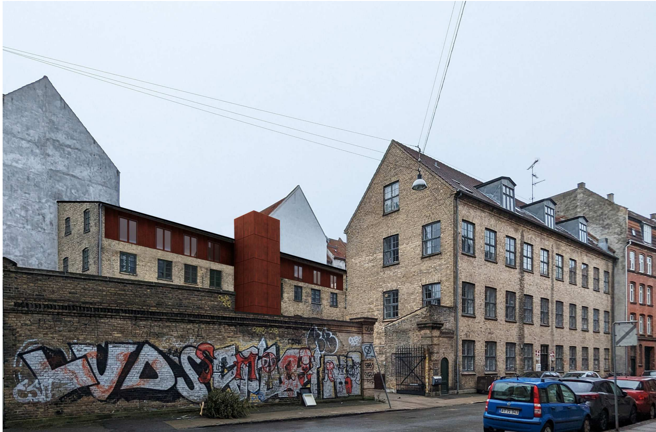
BAGHUSET SET FRA HANNOVERGADE
