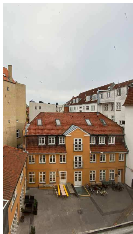
Facade af sidehus 2023
