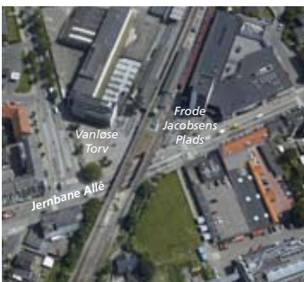
Luftfoto af jernbaneviadugten over Jernbane Allé.
