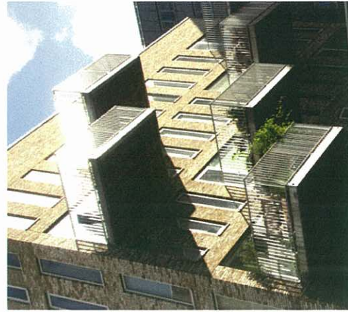
Dyb udenpå liggende altaner på brun teglfacade
