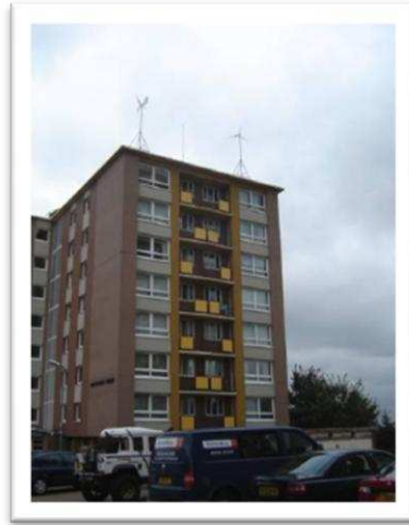
FIGUR 9: EKSEMPEL PÅ MINIVINDMØLLER AF TYPEN AMPAIR 600 230 MONTERET PÅ EN MELLEMLØR BYGNING I EN ENGELSK BY. (ENCRAFT, 2009)
