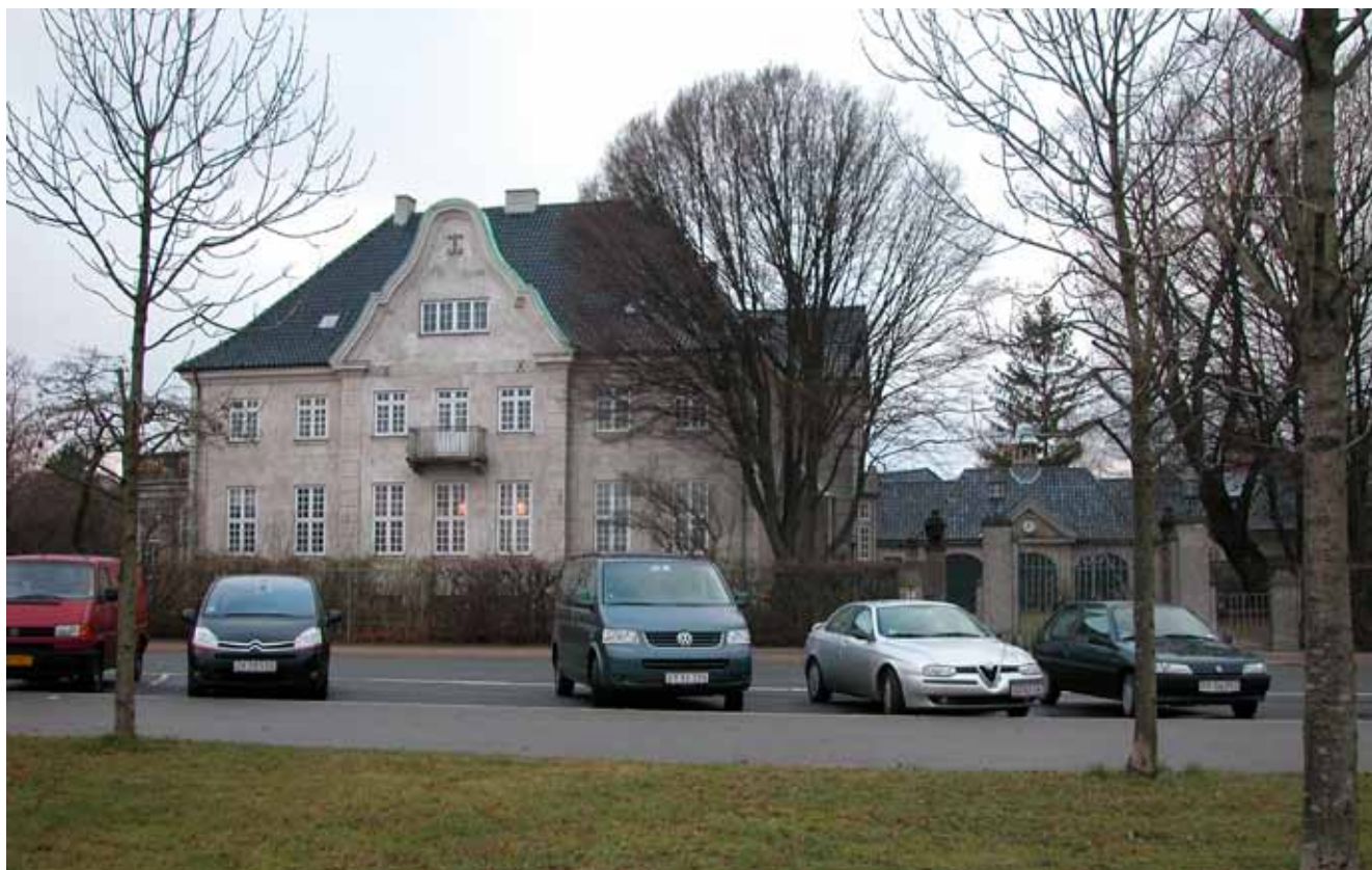
Strandpromenaden 33. Bygningsanlægget er opført i 1916 og er registreret på bevaringstrin 3 (høj bevaringsværdi).
