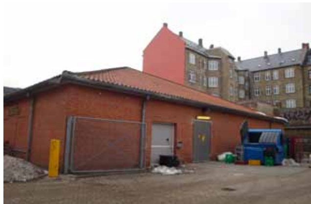
Nettobutikken på hjørnet af Middelgrundsvej og Strickersvej ønsker at udvide butikken og samtidig lave en lille tagterrasse til brug for opholdsareal for personalet.
