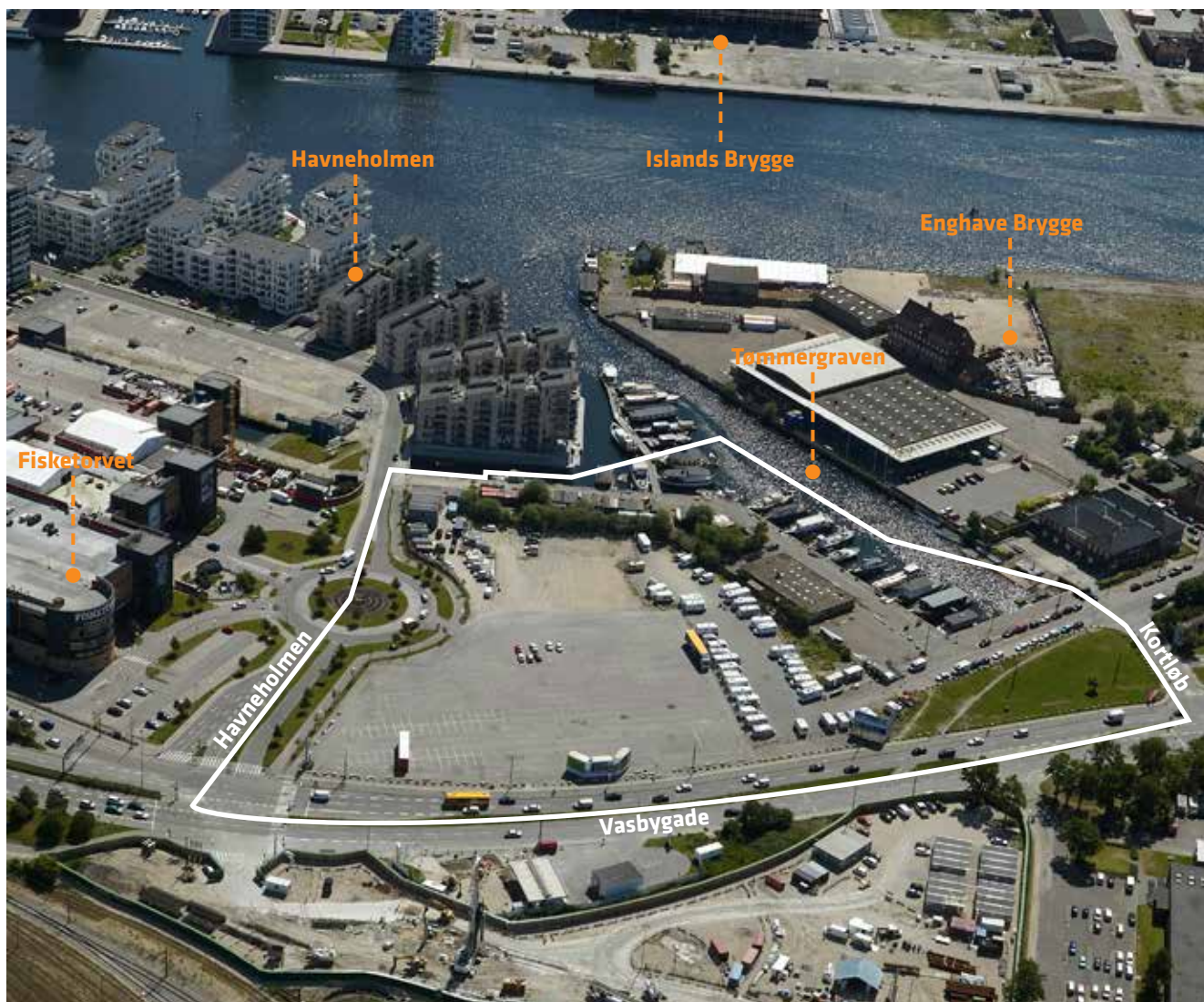
Luftfoto af lokalplanområdet set mod øst. Havneholmen, Fisketorvet/ Shopping Center, banearalerne, Vasbygade, Tømmergraven samt Enghave Brygge omkranser området. JW Luftfoto 2011.
