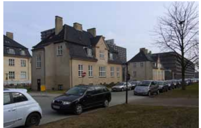
Den trefløjede bygning og de to villaer mod Amorparken tænkes nedrevet for at give plads til patienthotel- og administrationsbebyggelse.
