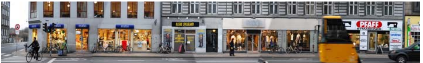
Fotocollage som viser facaderne fra Stengade til Griffenfeldsgade
