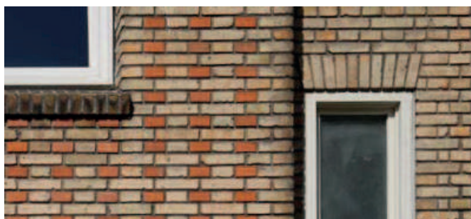
Eksempel på de eksisterende facader på blok 1-2
