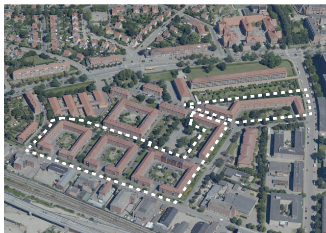
Luftfoto af Valby Ejendommene som er en afdeling spredt over flere gårdrum.
