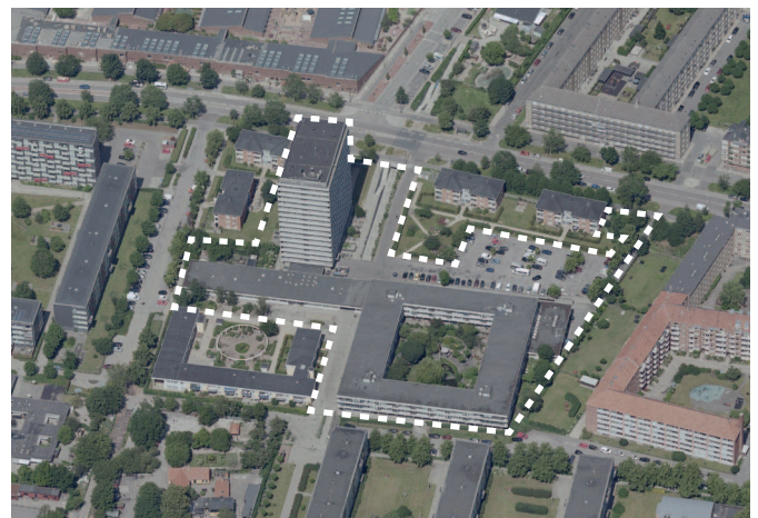
Luftfoto af Peder Lykkes Vej 61-65, hvor højhuset fremstår markant i bybilledet.
