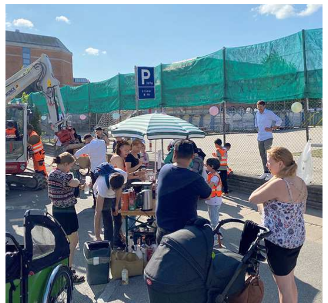
↑ Første spadestik på Ørnevej, Vibevej og Glentevej projektet (foto Københavns Kommune)
