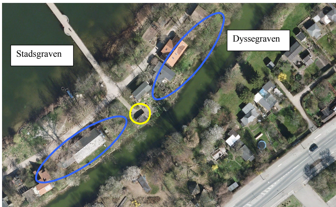
Luftfoto af området. Der anbefales anlagt en ny bro over Dyssenegraven i forlængelse af Dyssebroen. Det med gult markerede skur ligger i et eksisterende gennembrud af det fredede voldanlæg, der er markeret med blå.
