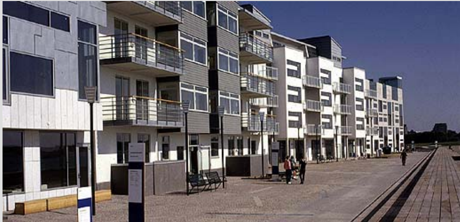
Strandpromenaden med masser af siddepladser på trækonstruktionen til højre i billedet.
