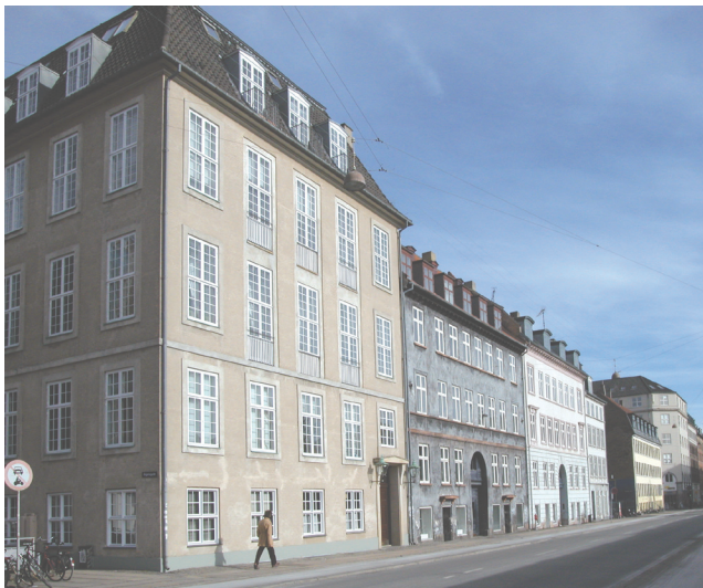
Karreens facade mod Sølvgade. De to 3½ etages porthuse er fredet. Lokalerne i høj kælder anvendes til forskellige erhverv. Karreens bebyggelse er generelt velholdt.
