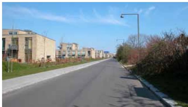
Digevej set fra syd mod DR's koncerthus som svagt skimtes i horisonten. Metroen ligger langs med bebyggelsen "Solstriben" mod vest.
