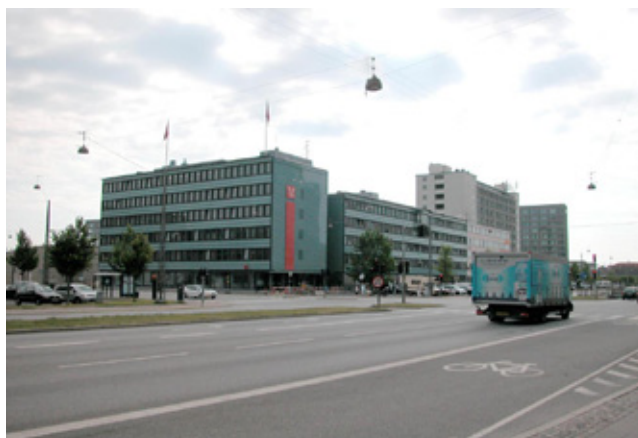
Falckhuset set fra Bernstorffsgade (eksisterende forhold).
