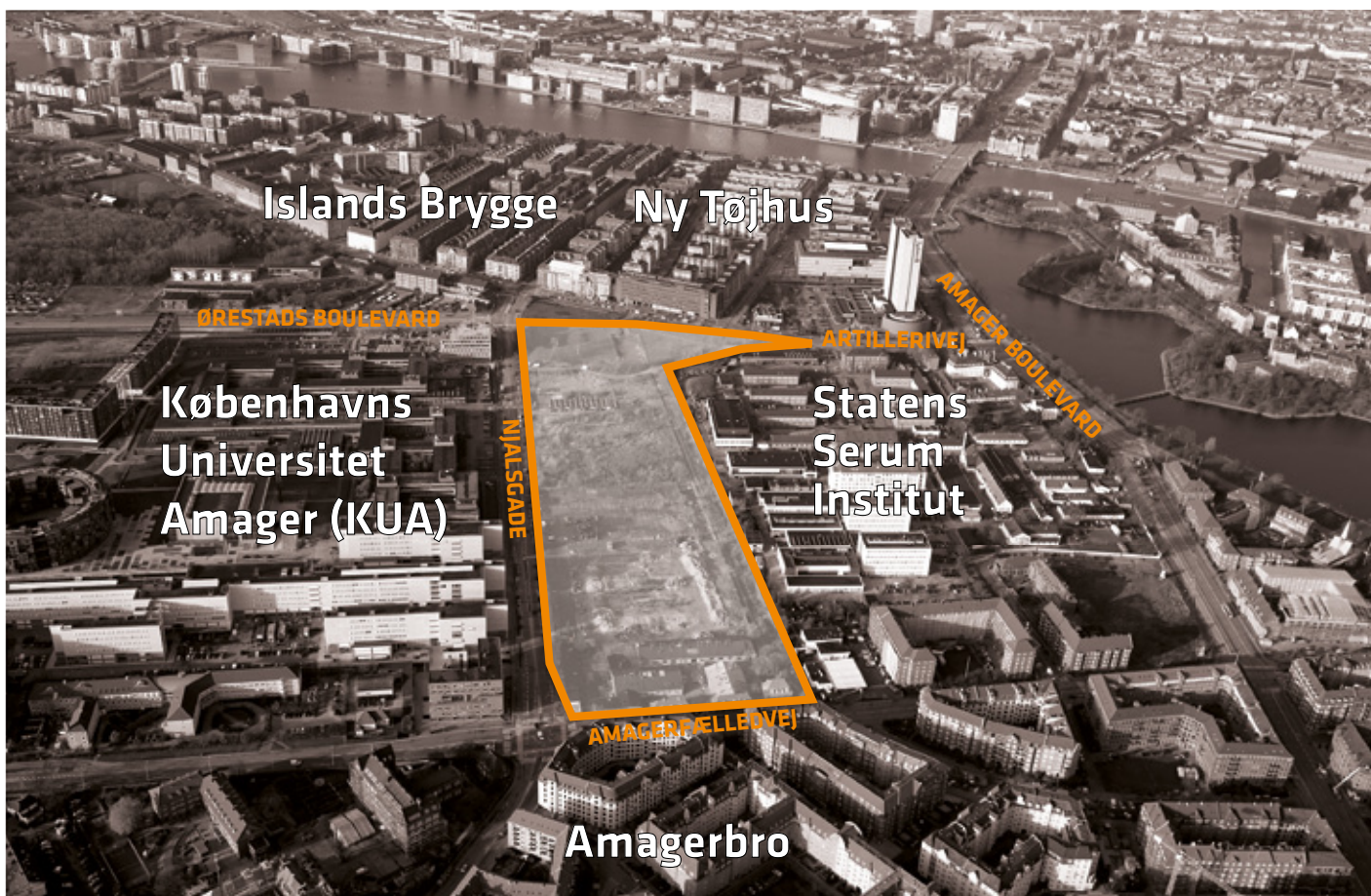
Luftfoto, der viser lokalplanområdet og dets beliggenhed og sammenhæng med de tilgrænsende bykvarterer
