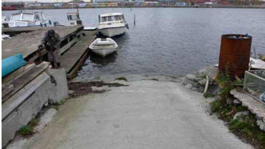
Eksisterende sliske i betonkanten
