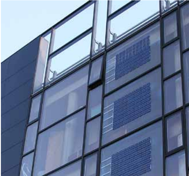
Solpaneler i glasfacade Dannebrogsgade 49
