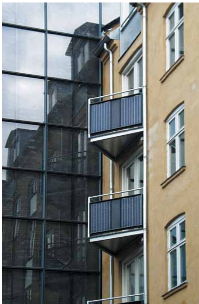
Eksempel på anvendelse af solenergi på gavl og altaner
