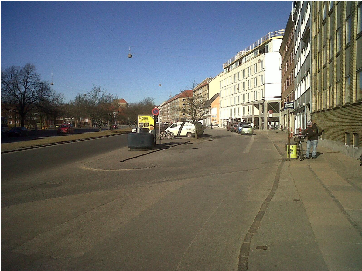
Figur 38. Svinget mellem Peter Ipsens Allé og Hulgårdsvej, hvor projektet giver mulighed for etablering af et byrum med mulighed for ophold
