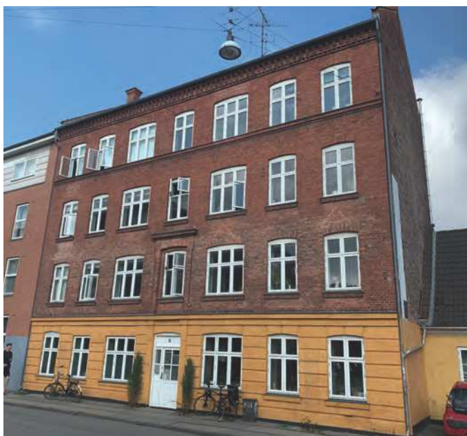
Nordvendt gavl efterisoleres
