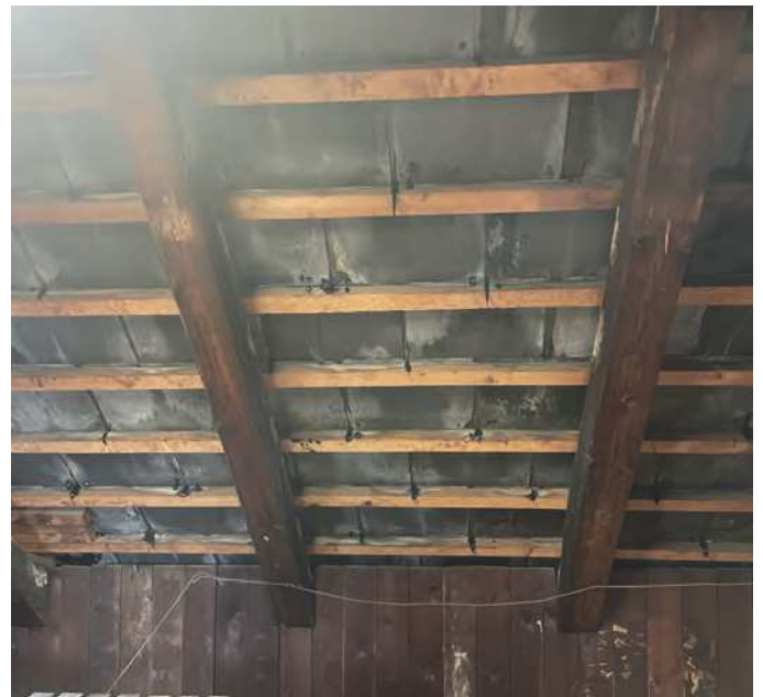
Der efterisoleres og etableres undertag
