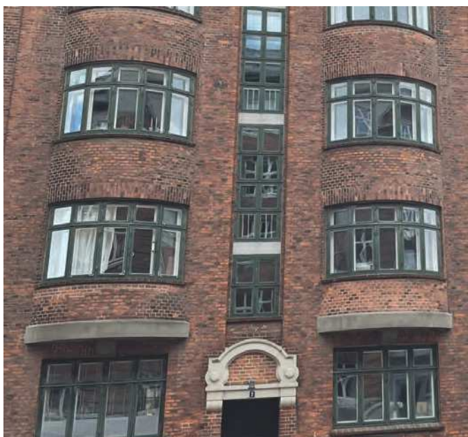
Renovering af originale vinduer
