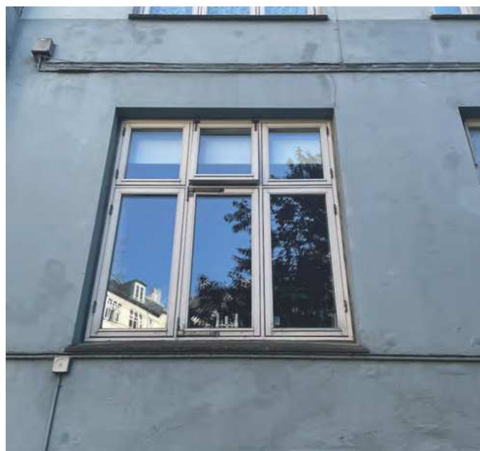
Ejendommens vinduer udskiftes, primært på gårdfacade
