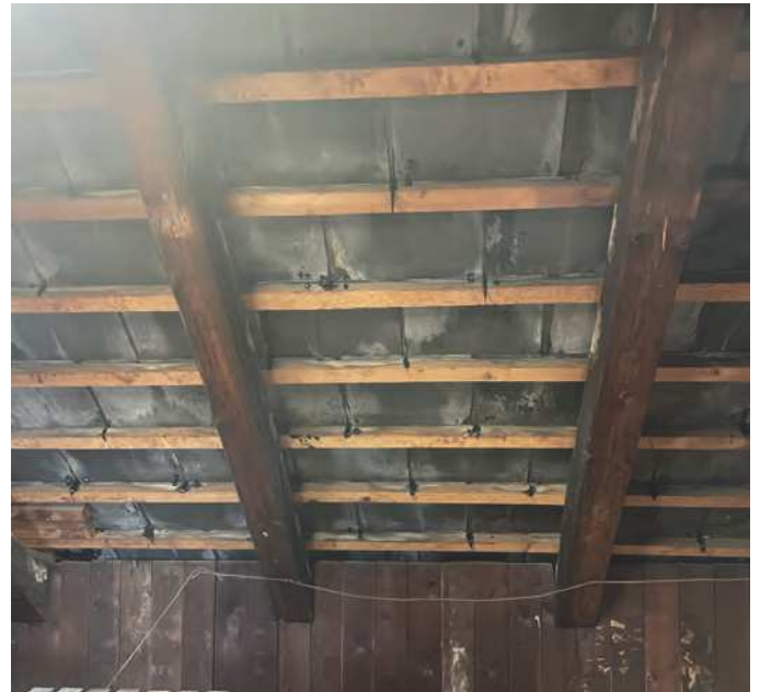
Der efterisoleres og etableres undertag
