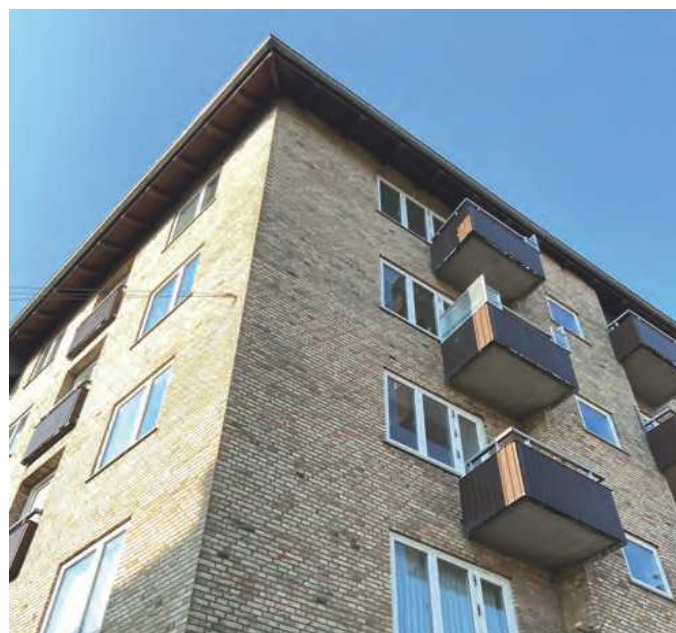
Brandsikring udføres blandt andet ved tagfod
