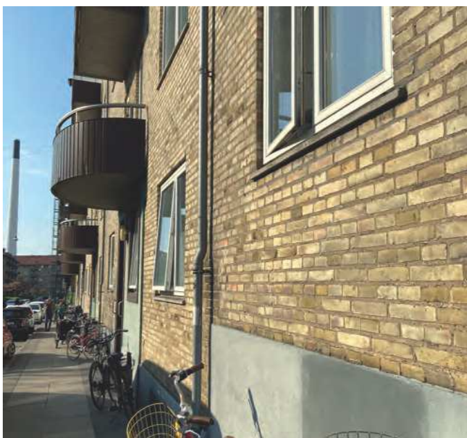
Vinduesbrystninger efterisoleres
