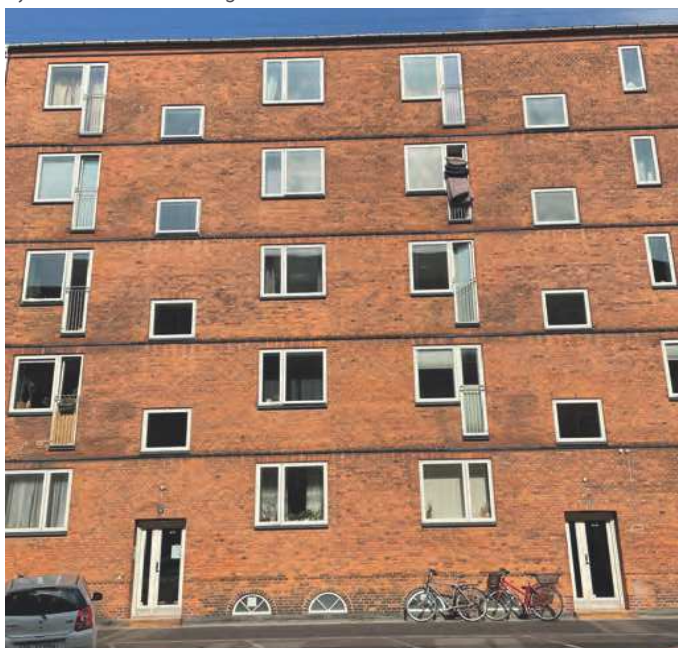
Ejendommen set fra gaden
