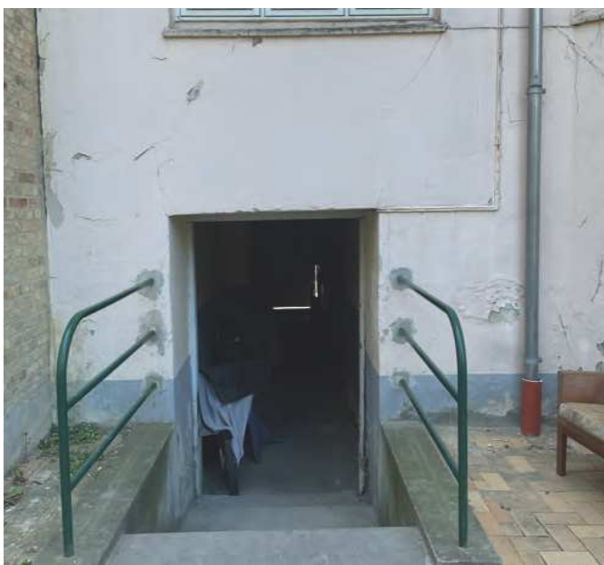
Efterisolering af kældersport mod beboelse, genopretning af gårdfacade
