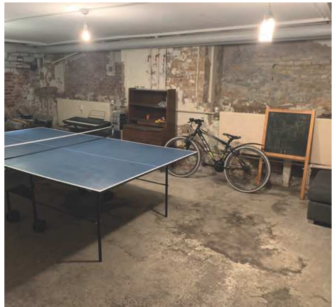
Fugtsikring af kælder
