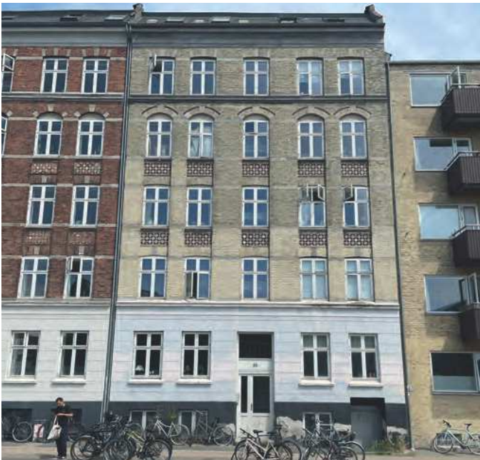
Ejendommen set fra gaden
