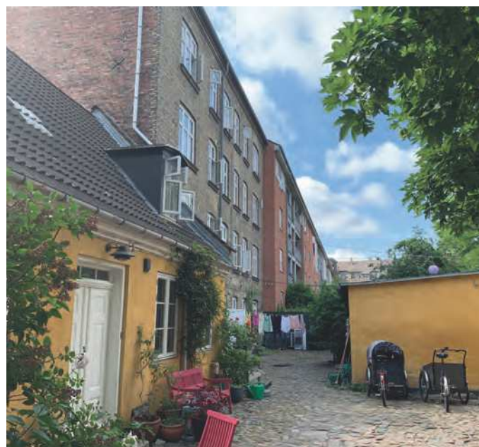
Belægninger og brønde skybrudssikres
