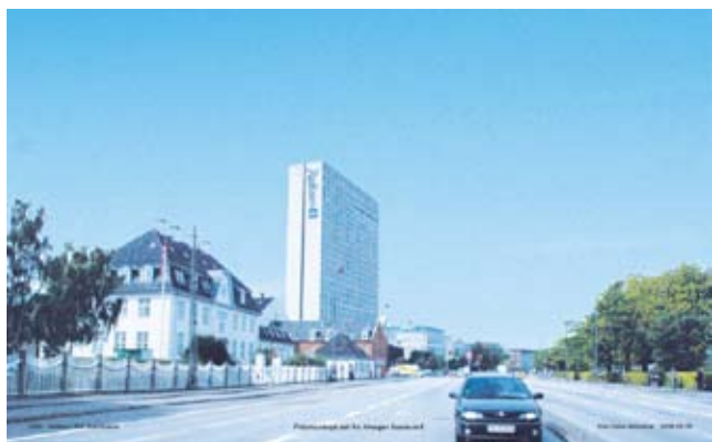
Eksisterende forhold set fra Amager Boulevard.
