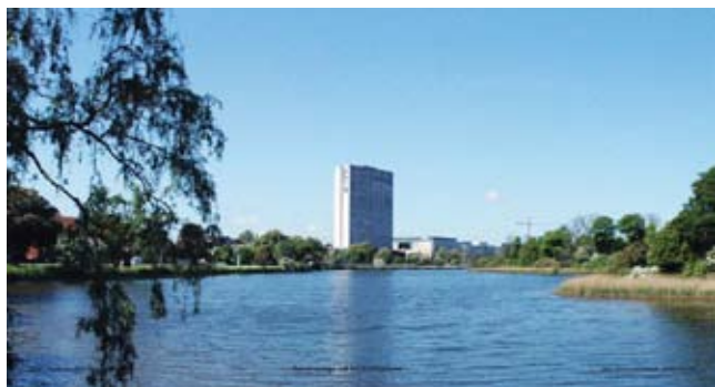
Eksisterende forhold set fra Stadsgraven.
