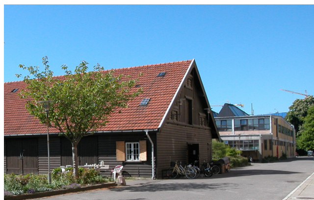
Bevaringsværdig bygning med opbevaring af materiel
