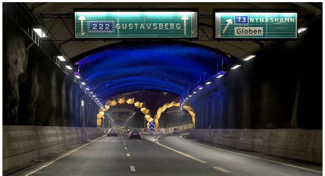
Figur 13: Underjordisk frakørselsrampe i tunnelkonstruktion, Södra Länken, Stockholm
