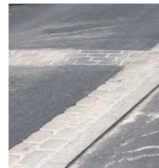
Asfalt og kantsten
