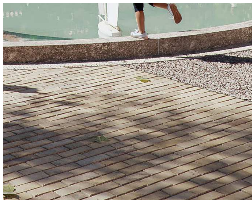
Ny klinkebelægning og granitkant ved vandspejl
