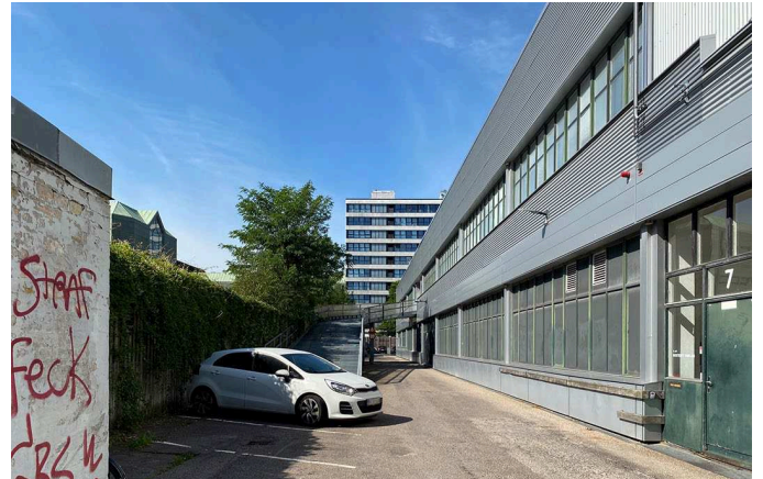
Kig ind på lokalplanområdet fra Bryggervangen langs det sydlige skel. Højhuset ses i baggrunden.
