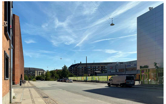
Kig fra Sejrogade ned mod Skt. Kjelds Plads og den nordlige del af lokalplanområdet. Her ses karrévarterets kant op imod pladsen og Bryggervangen i baggrunden.
