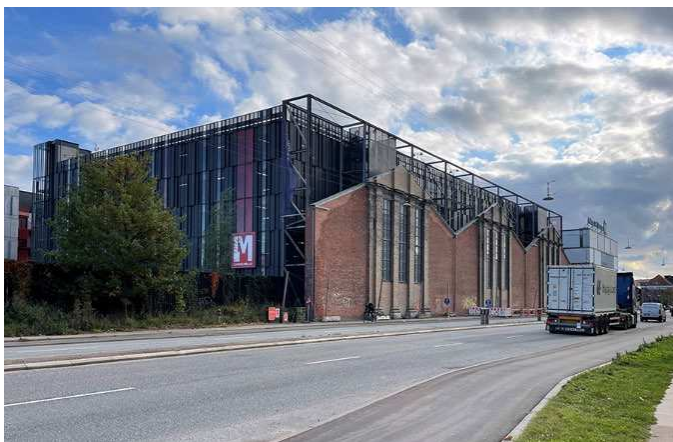
Billede fra stedet - kik mod syd ad Scandiagade. 'Den grønne Kile' ses til venstre. Til højre ses parkeringshuset, der ligger lige uden for tillægsområdet.
