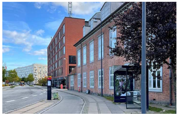
Billede fra stedet - kik mod øst ad Tegholmegade. Den bevaringsværdige bygning Tegholmegade 2 ses til højre bagved busstoppestedet for linje 2A.
