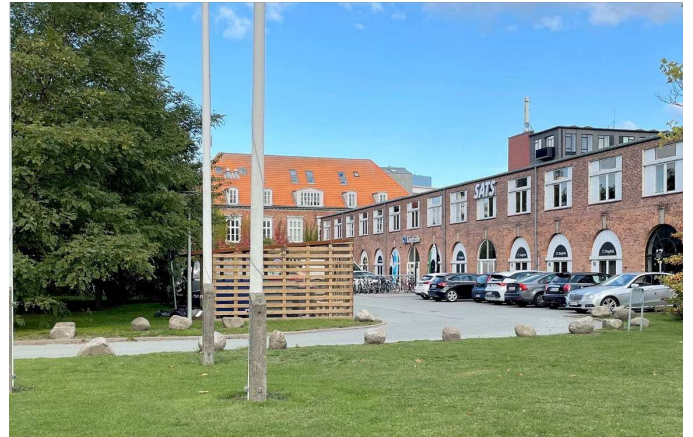
Billede fra stedet - parkeringspladsen og de eksisterende bygninger set fra syd mod nord.
