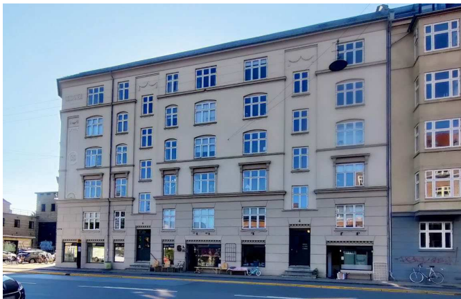
Facaden for Kastrupvej 4 og 6 set fra den modsatte side af Kastrupvej; caféen Perlemors Kaffebær er beliggende mellem de to opgangsdøre.
