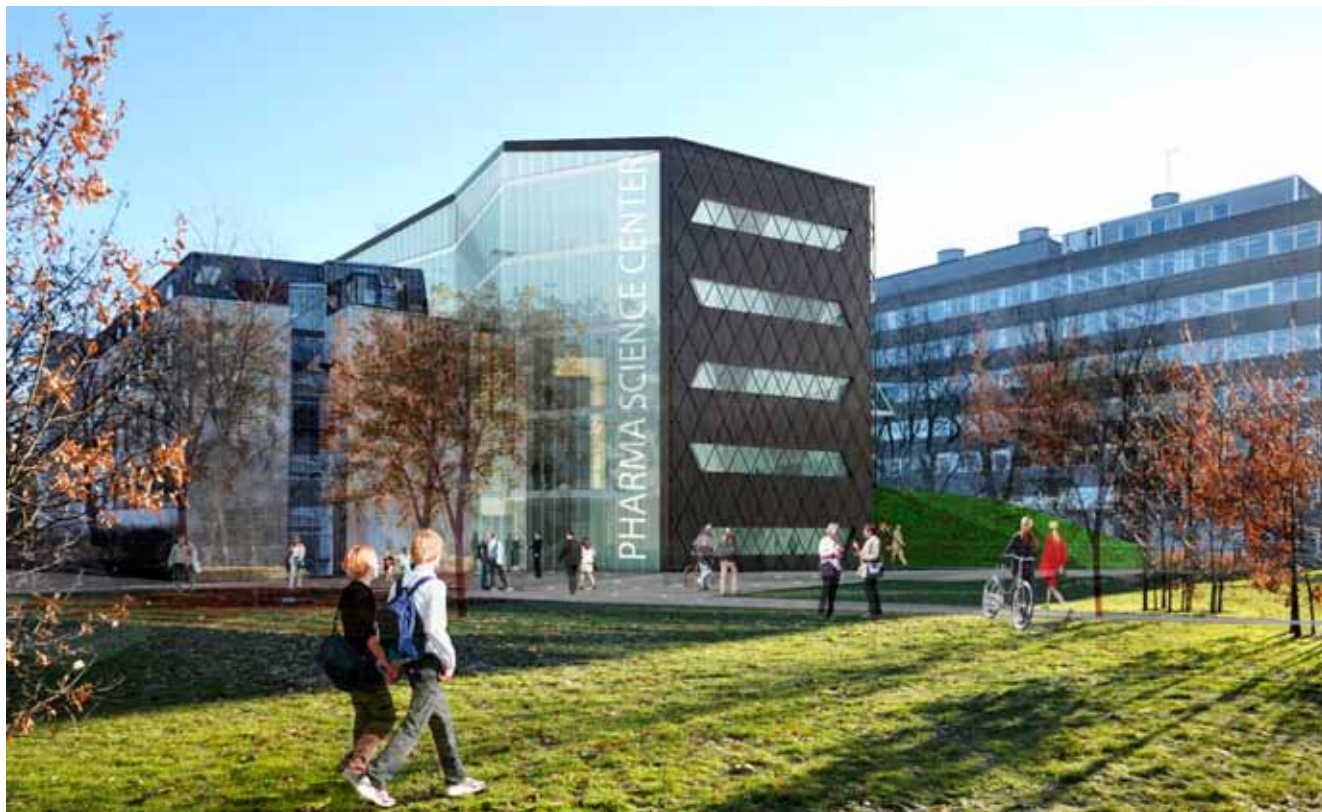
Visualisering af indgang til Pharma Science Center set fra grønningen mellem Jagtvej og Nørre Allé.
