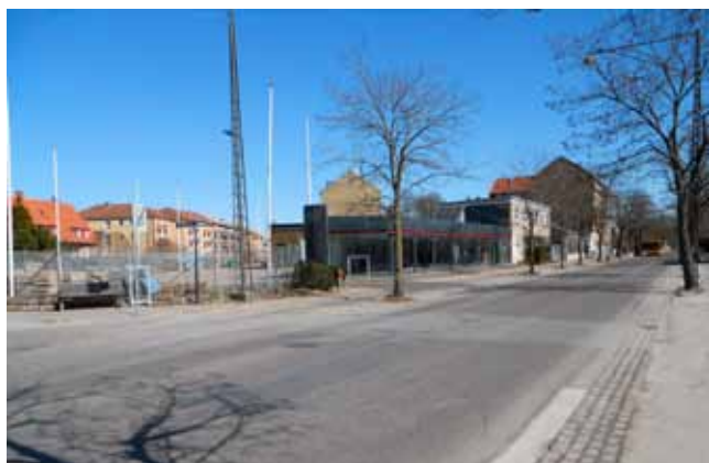
Allébeplantningen langs Apollovej giver området et grønt præg. Parkeringsarealet samt erhvervs og karrébebyggelsen ses til venstre i billedet.
