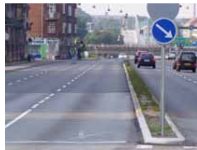
Støjreducerende vejbelægning på Lyngbyvej
