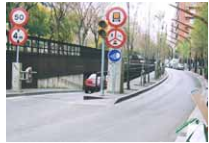
Overdækning af 4-sporet ringvej i Barcelona
