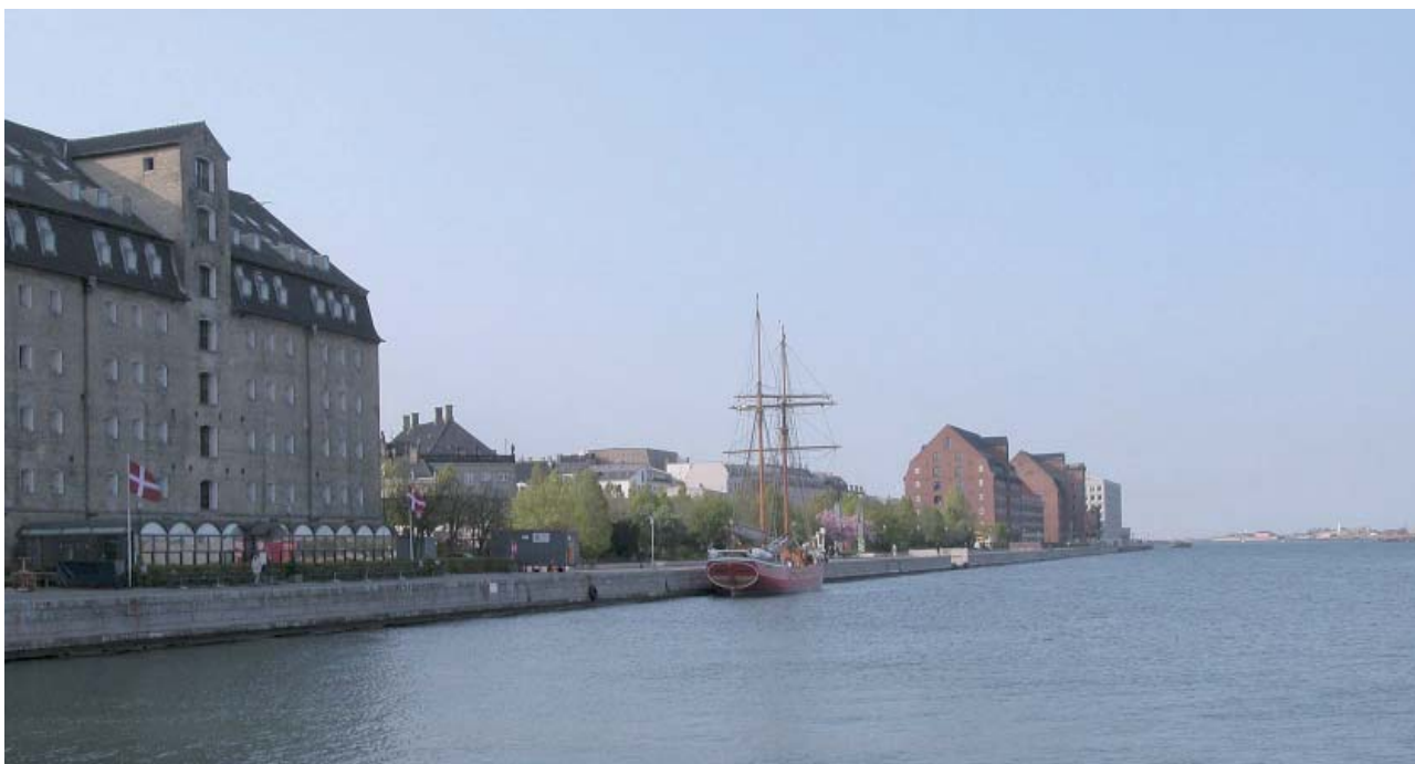
Havnerummet præges i særlig grad af de bevarede, ombyggede pakhuse
