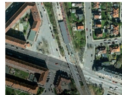
Herman Bangs Plads og området omkring Langgade Station set fra luften.
