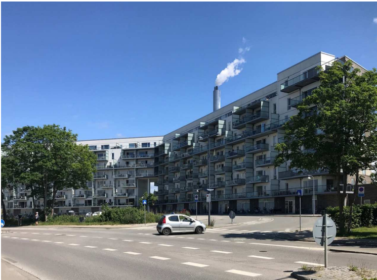
Det grønne areal til venstre i billedet er matrikel 650bs Christianshavns Kvarter, og med den 8 etagers boligbebyggelse i baggrunden. Skorstenen er Amager Bakke.
