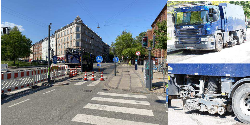
Figur 10. Rensning af asfalt.
