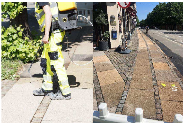
Figur 8. Applicering af NOxOFF imprægneringsvæske og fliserne mens de tørrer.
