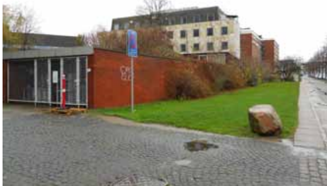
Byggfeltet set fra Nørre Allé med Bygning 17 bagerst. De lave bygninger forrest skal nedrives.
