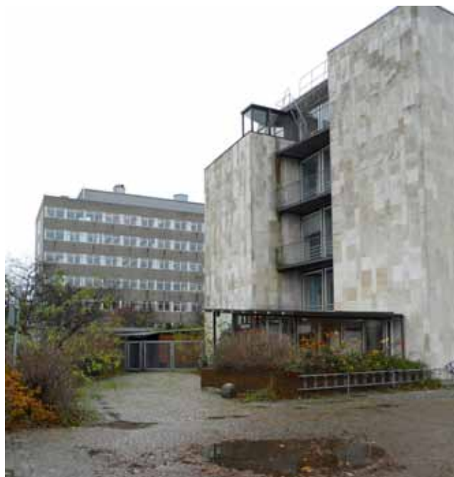
Det Farmaceutiske Fakultet set fra Nørre Allé med byggfeltet mellem Bygning 17 forrest og Bygning 13 bagerst.
