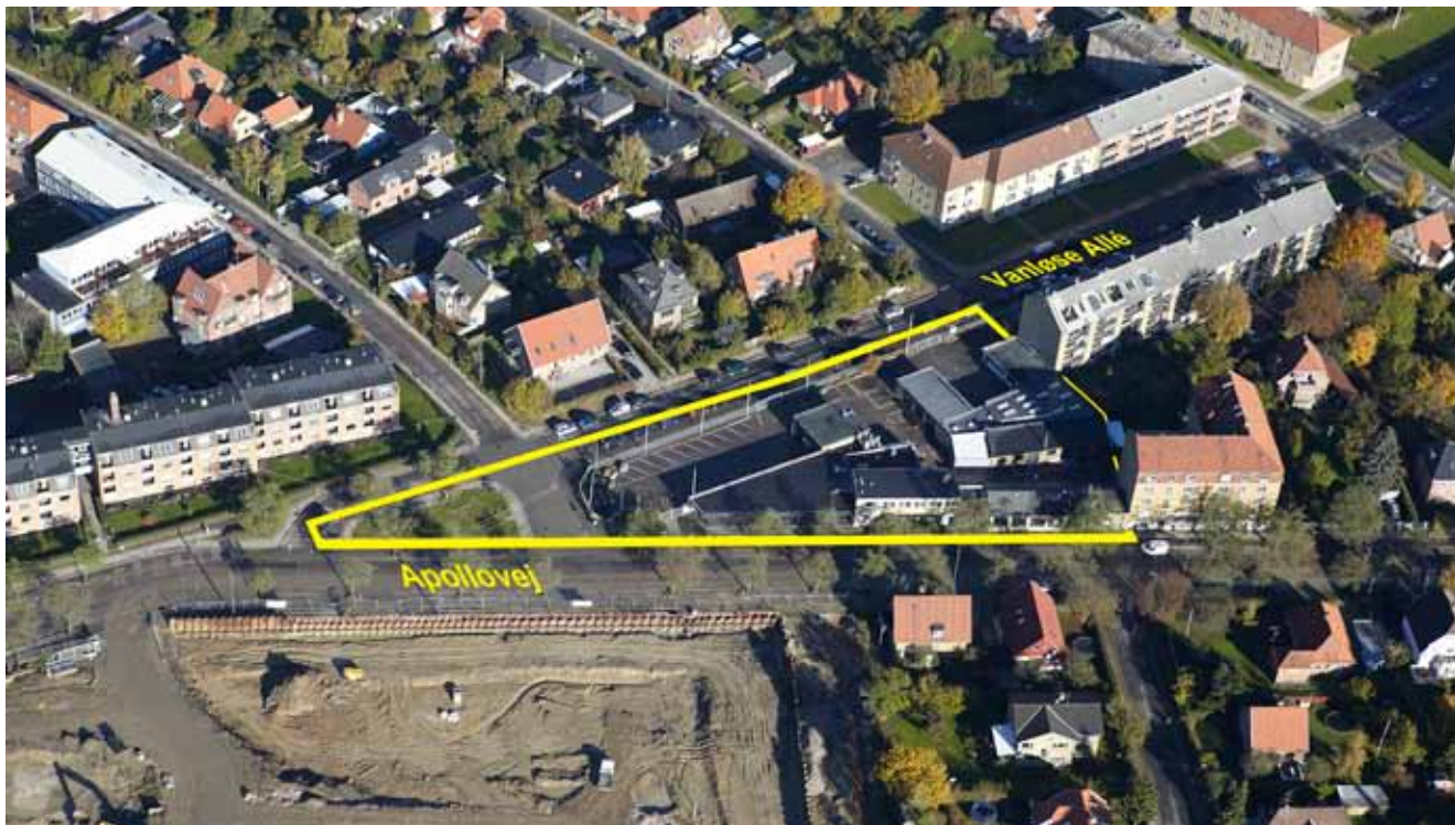
Luftfoto af planområdet og dets omgivelser set fra nord (JW luftfoto oktober 2010).
