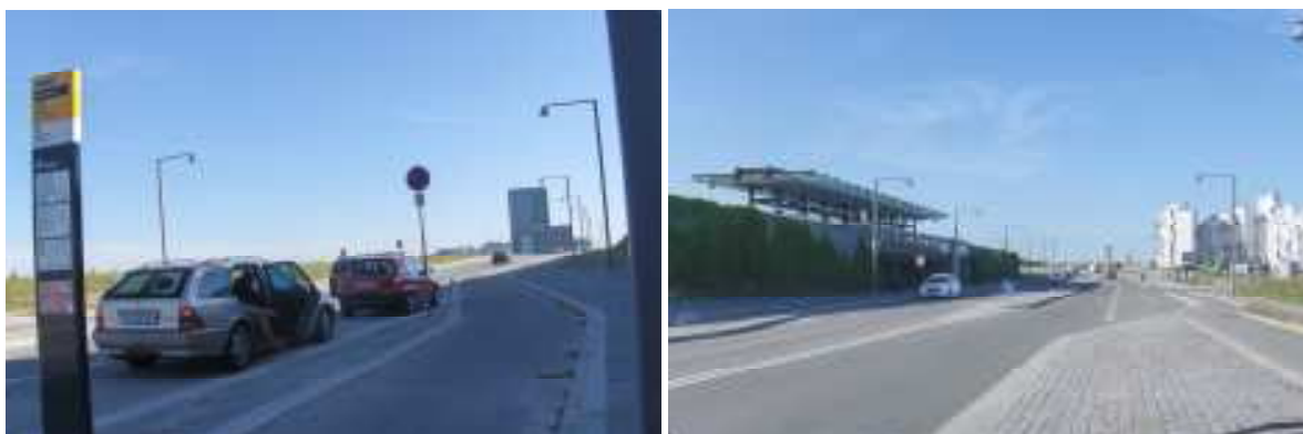
Foto 13: Afsætning i buslommen ved stationen
