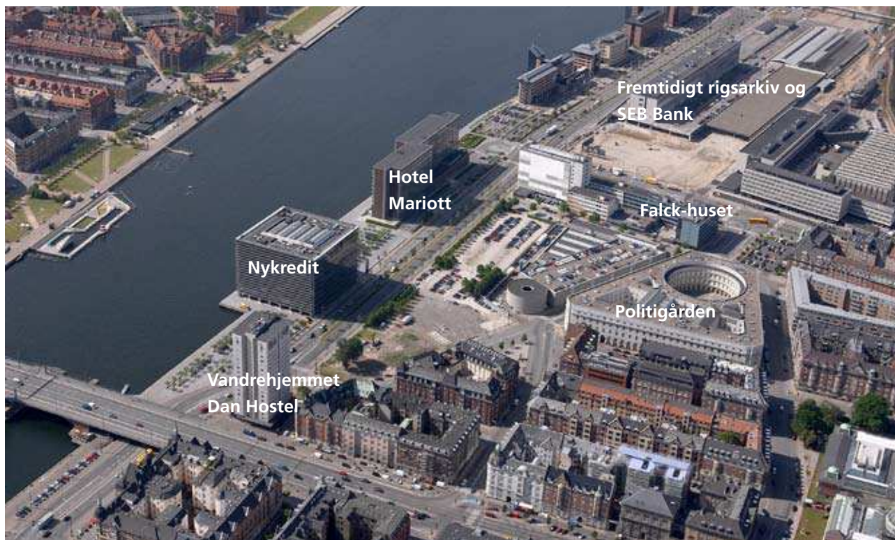
Luftfoto af lokalplanområdet omgivet af ældre karrébebyggelse, og større eksisterende og fremtidige bygningsvolumener.
