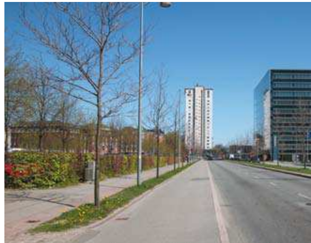
Byggegrunden til venstre set fra Kalvebod Brygge mod Dan Hostel, højhuset ved Langebro.
