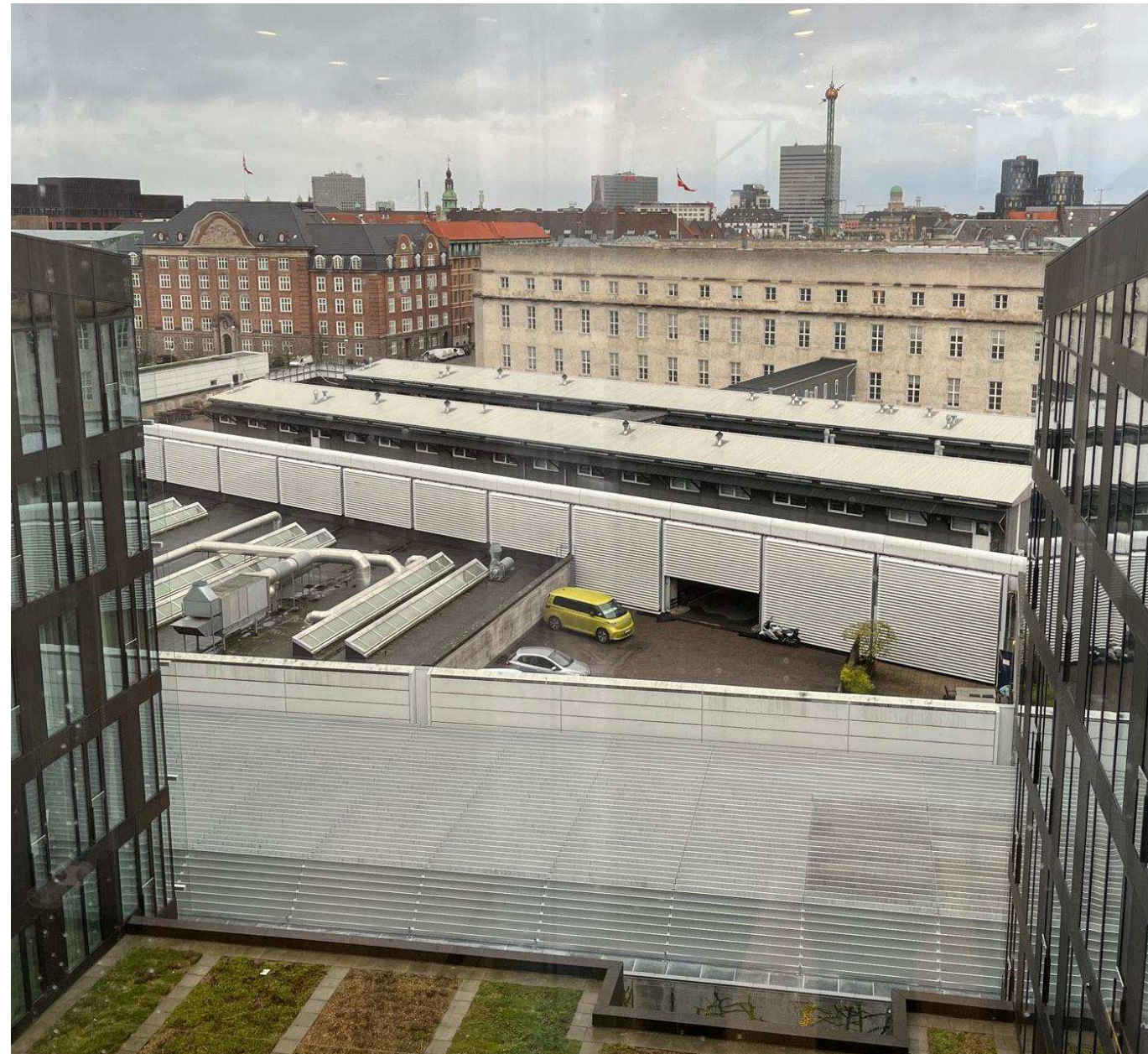
Nuværende midlertidige pavilloner: Kig fra hotel byggefelt B, mod garagetaget byggefelt C
