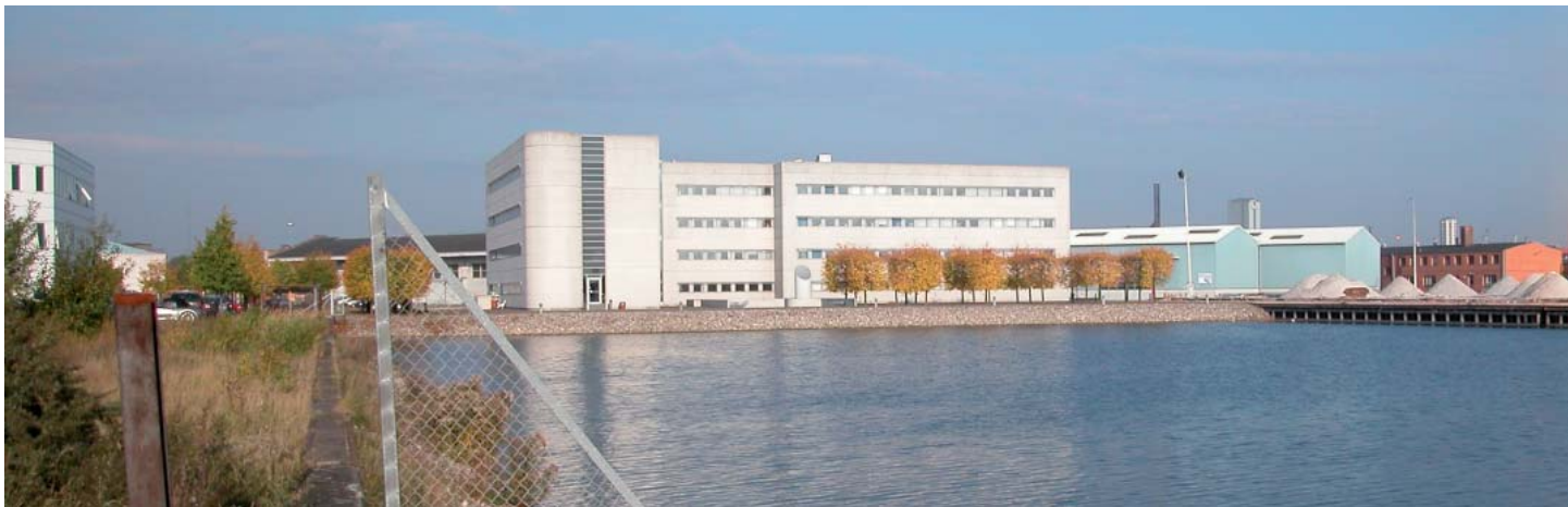
Frederiksholmsløbet set fra Nordre Teglkaj. I forgrunden til venstre ses LMG's eksisterende kontorhus og til højre i billedet "pladehallen".
