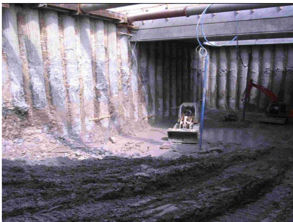
Figur 4.13 Udgravning af stationsboks mellem primære støttevægge udført med sekantpæle i armeret beton, Københavns Metro.
