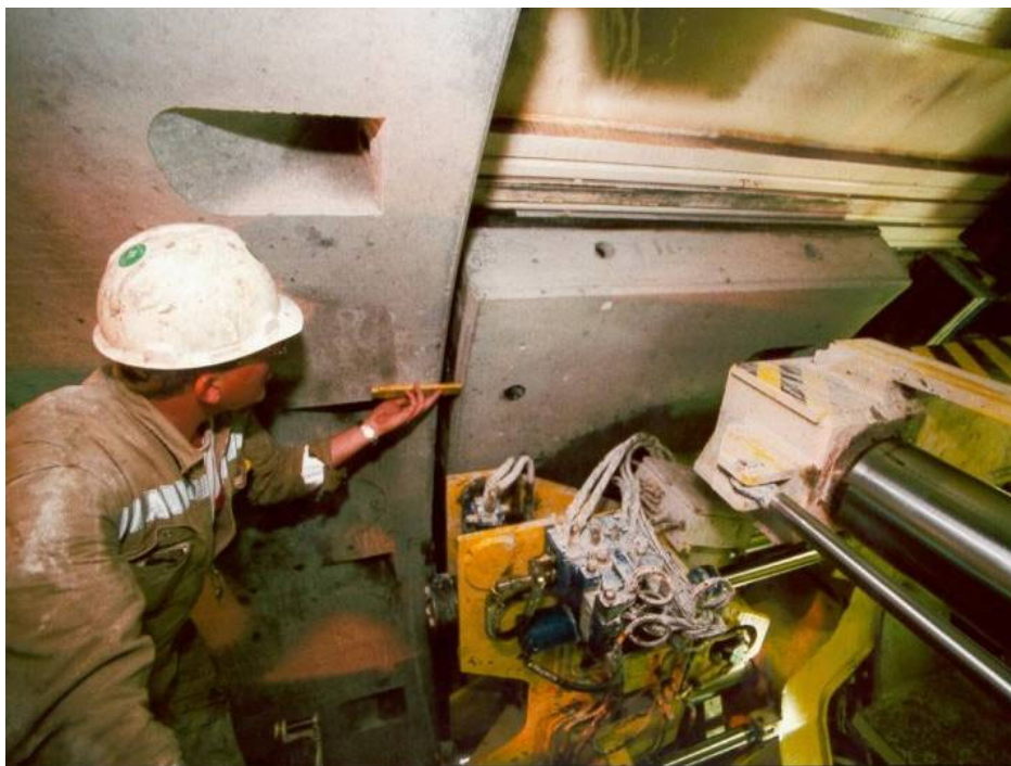
Figur 4.5 Montering af betonelementer i tunnel, Københavns Metro.
