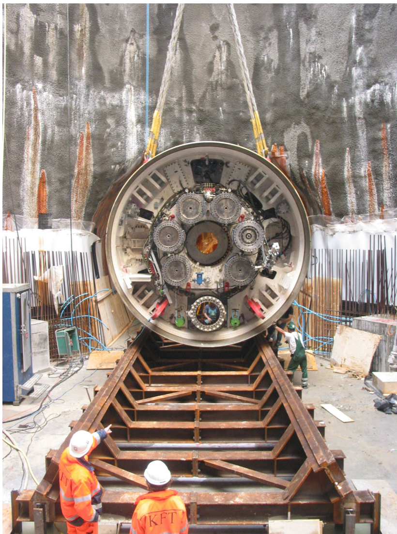
Figur 4.16 Samling af TBM i startkammer, KE Fjernvarmetunnel (København 2006).
