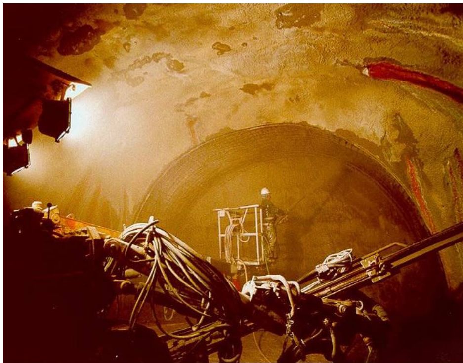
Figur 4.10 Påføring af sprøjtebeton i kaverne, Københavns Metro.
