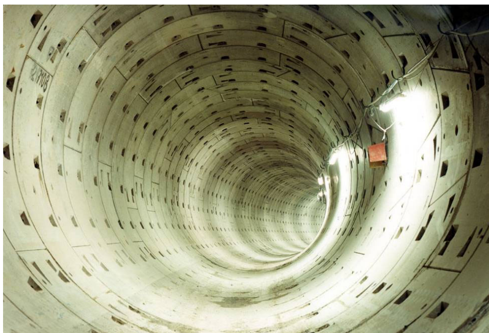
Figur 4.4 Tunnelrør beklædt med præfabrikerede betonelementer, Københavns Metro.
