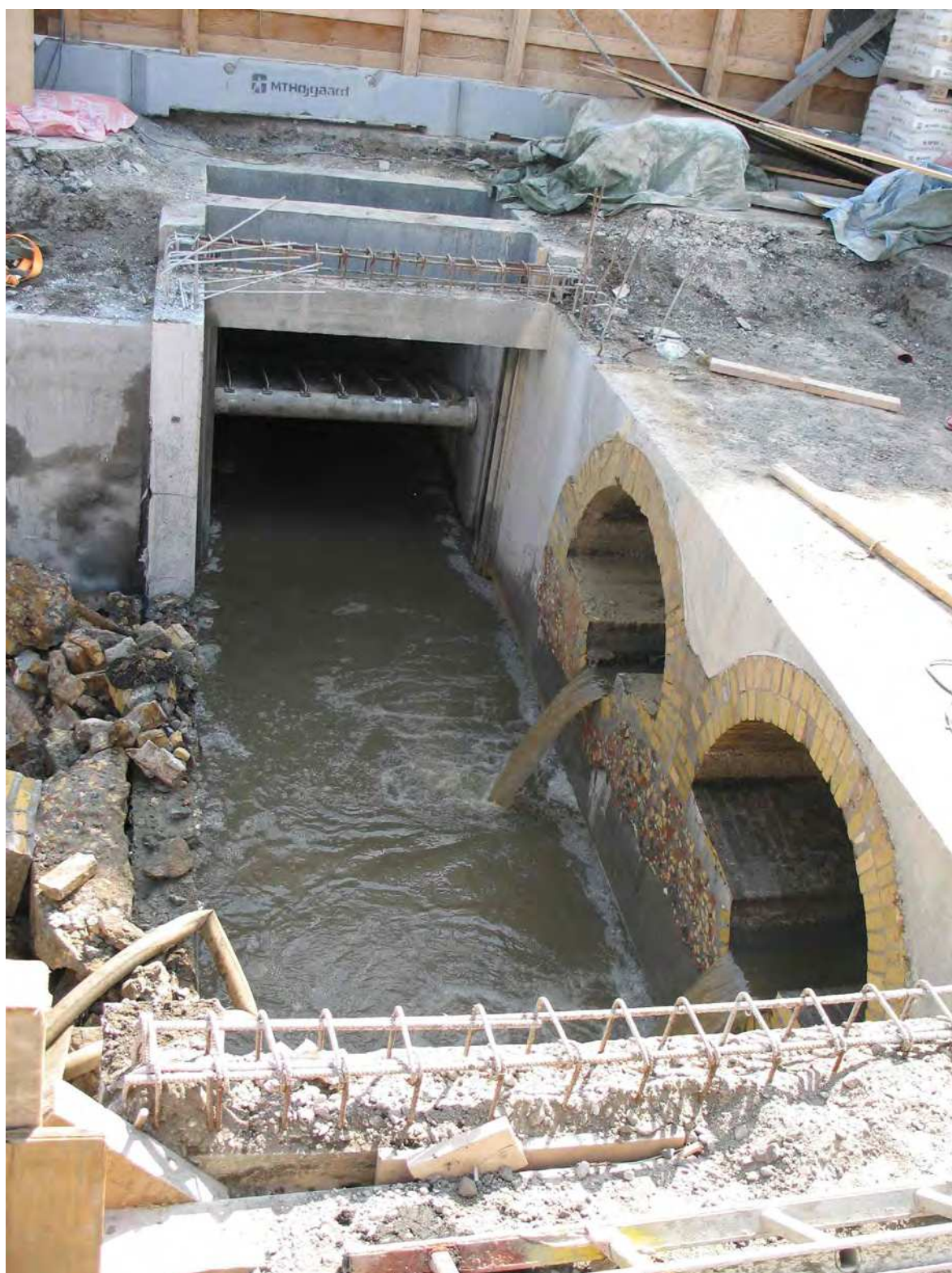
Foto 9 Gammel muret dobbeltledning, anlægsarbejder i forbindelse med Sankt Annæ Plads-projektet
