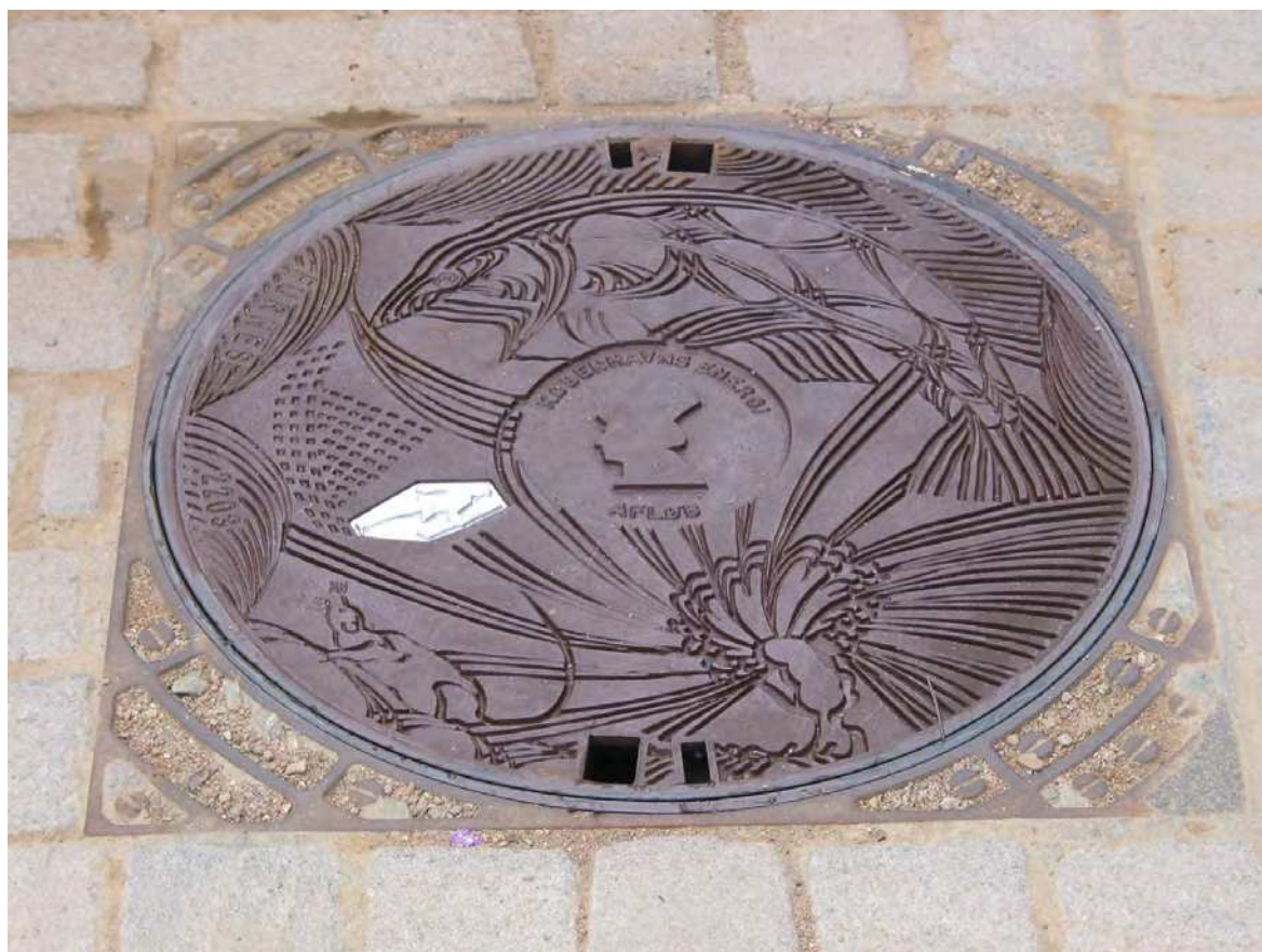
Foto 14 Kloakdæksel designet i forbindelse med 200-året for H. C. Andersens fødsel
